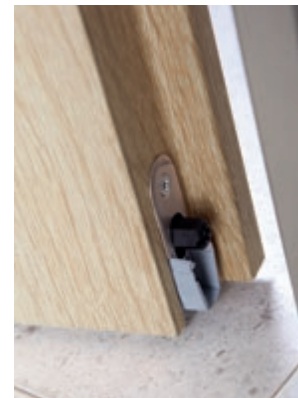
Standardausstattung bei Schallschutztüren: mechanisch absenkbare Bodendichtung
